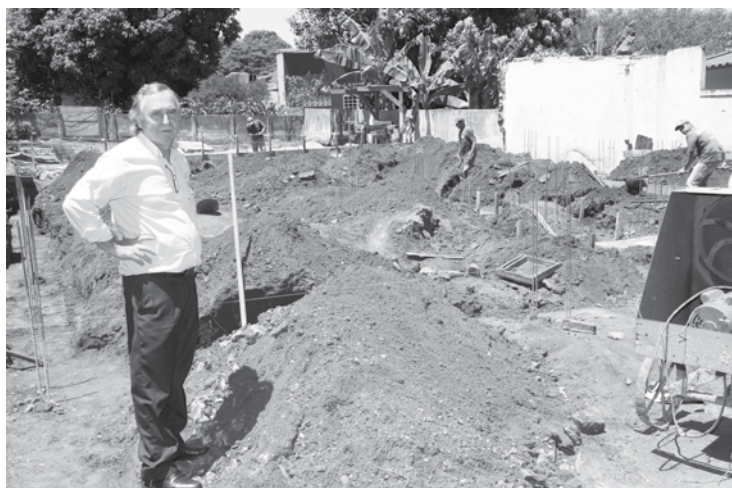
Dr. Edson Olivatti durante visita ao início das obras da OAB - Subseção Nova Esperança
