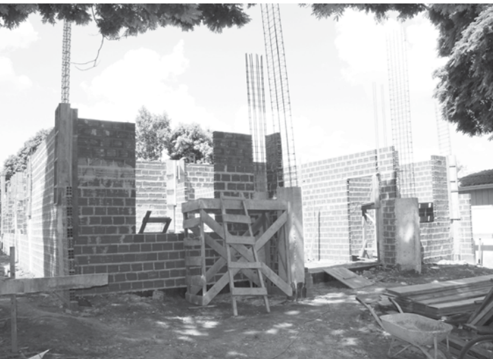
Em menos de um mês a obra vem ganhando forma do que será a futura sede própria da OAB - Subseção Nova Esperança
