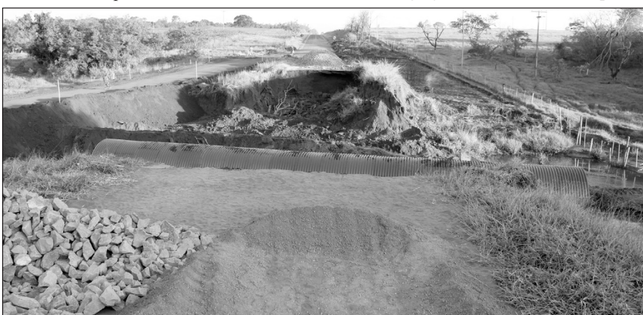
Já no km 68,50 da rodovia PR-542 trata-se de um bueiro metálico de 2,8 m de diâmetro. É a região da nascente do Córrego Lupion, manancial que abastece com água potável a cidade de Itaguajé. Numa extensão de 20 metros a obra depois de pronta vai custar ao estado 526 mil reais
