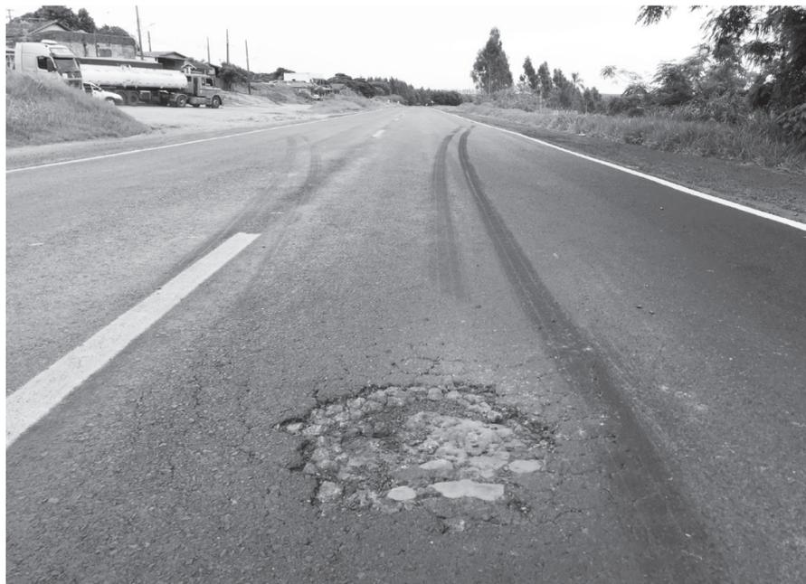
No trecho de recape da PR-463 próximo ao entroncamento com a BR-376 em Nova Esperança, o novo asfalto já apresenta deformações e buracos
