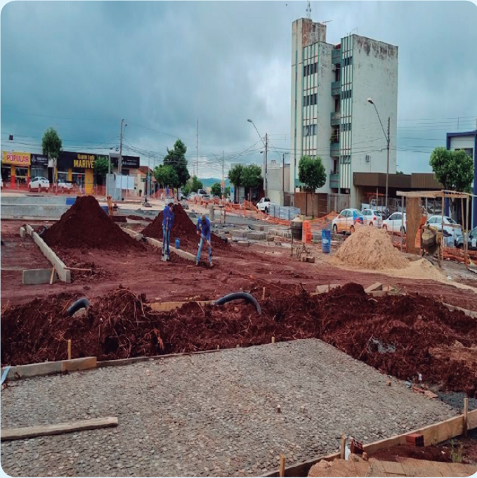
Regularização do terreno, fonte própria
