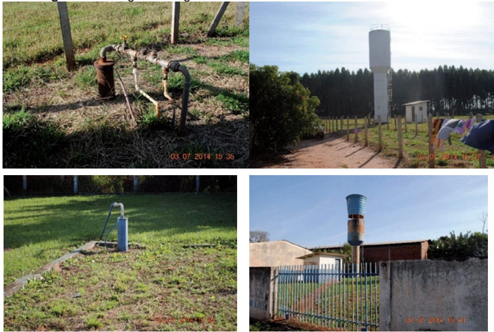
Figura 3.8 - Registro fotográfico dos reservatórios localizados no Km 14
