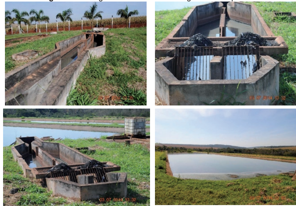
Figura 3.14 - Lagoas de tratamento de esgoto e calha parshall
