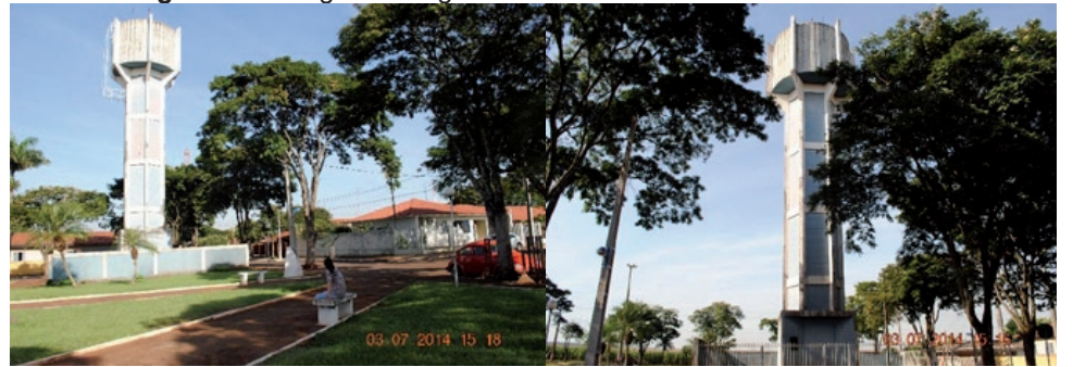
Figura 3.4 - Registro fotográfico dos reservatórios – área urbana
