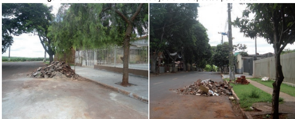
Figura 3.28 - Resíduos de construção civil dispostos para coleta
