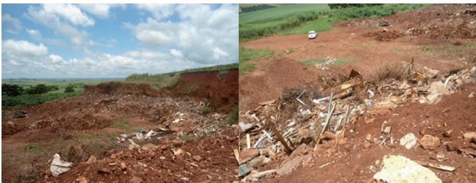
Figura 3.27 - Disposição final dos entulhos coletados
