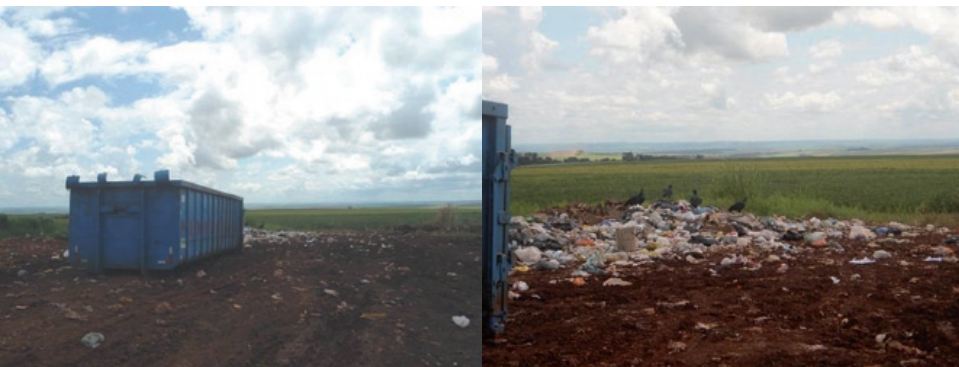
Figura 3.40 - Estação de Transbordo
