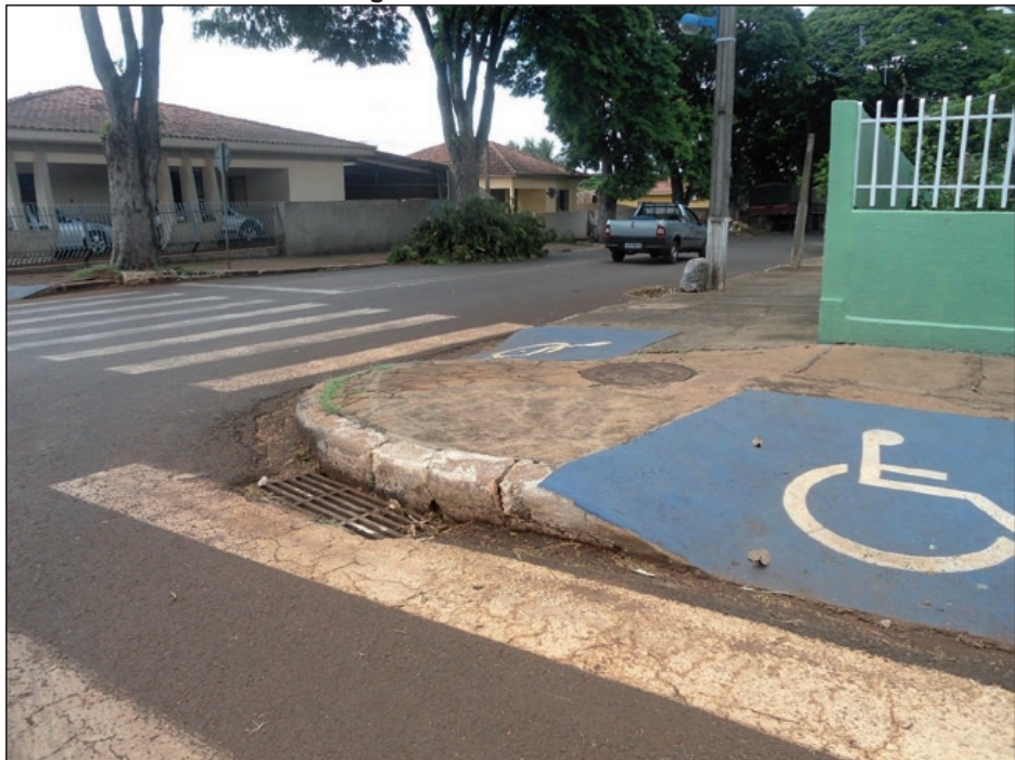
Figura 3.46 - Bocas de lobo
